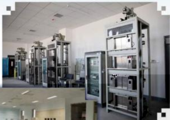
智能电梯安装调试 维护训练场所
